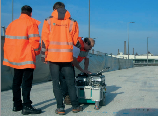
BetoScan bei der Prüfung einer Brücke
